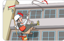
달비계를 사용하여 건물 외벽 청소 구명줄 미설치
